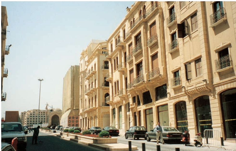
1999. Aspecto de Beirut reconstruido.
