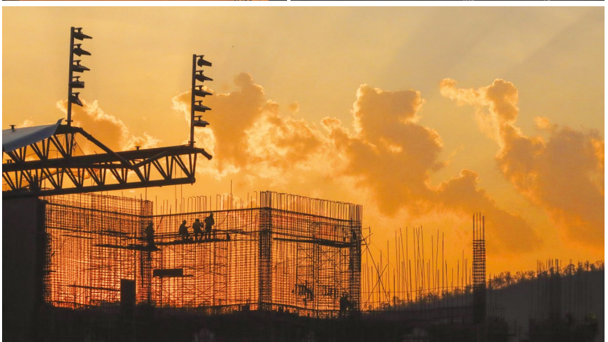
Momentos y detalles del proceso de construcción del Estadio Yu'va . Fotografías: Eduardo González
