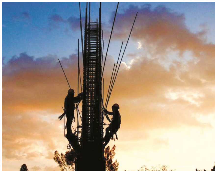
Construcción del nuevo estadio de beisbol en Oaxaca. Fotografía: Eduardo González
